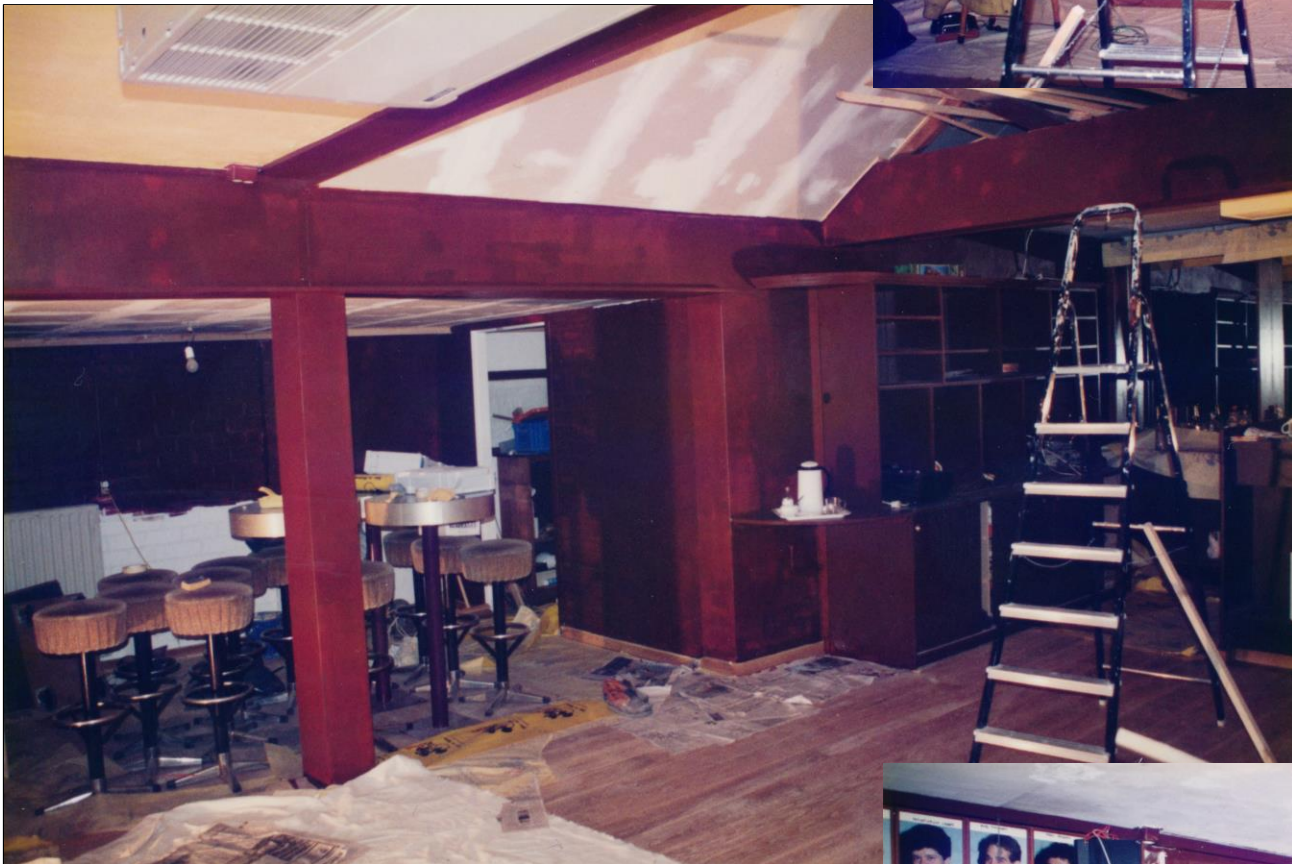
Het plafond ging er letterlijk uit. In de aanbouw ruimte voor een geluidkast en voetbalspel, dames- en herentoilet
