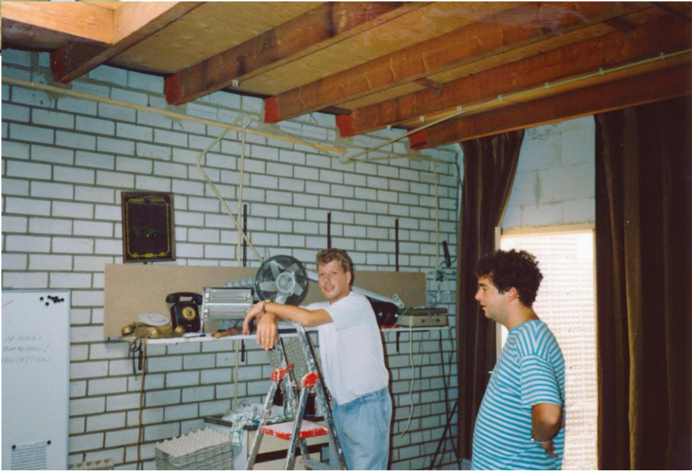
Renovatie, iedereen stak de handen uit de mouwen
